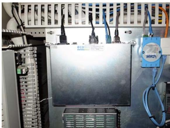
Aquarius 管理&自動システム (Aquarius MAS) は、ケーイーアイシステム社と共同で開発した最先端の船舶用コンピューターシステムで、データログ、アラーム管理、システム作動状況監視を含む多様な役割を満たすシステムです。
