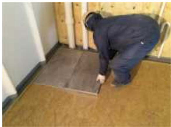
(b)浮床敷き詰め作業
