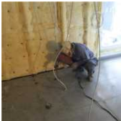
(c)浮床継ぎ目のタップ溶接
