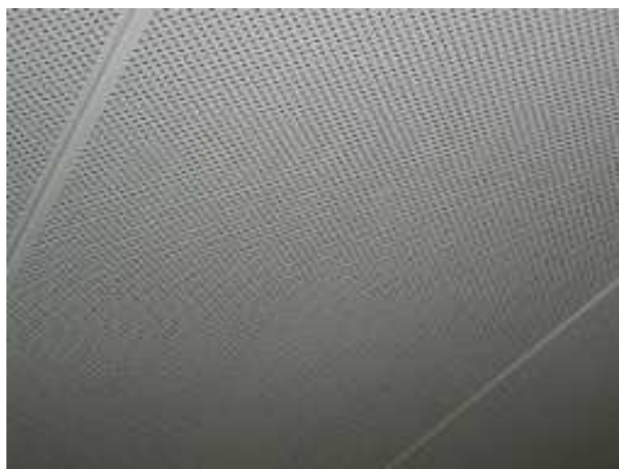
写真 2.1-1 天井多孔質パネル
