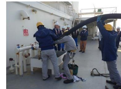
燃料供給管の本船への接続
