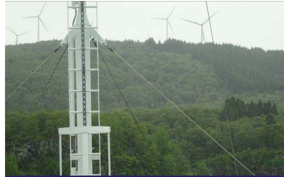
風力発電所(電力源)
