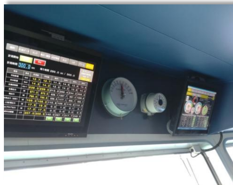
陸サポモニタ（操舵室）
