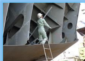
建造中の工事監督の様子
