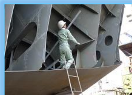
建造中の工事監督の様子
