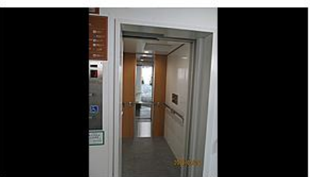
エレベーター
