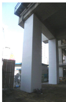
施工後 (柱に鋼板を巻き補強)
