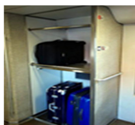
荷物置き場の設置
