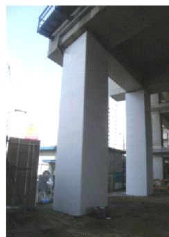
施工後 (柱に鋼板を巻き補強)
