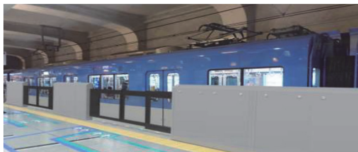
ホームドア整備
