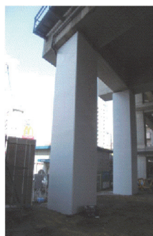
施工後 (柱に鋼板を巻き補強)
