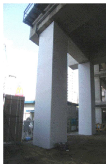
施工後 (柱に鋼板を巻き補強)
