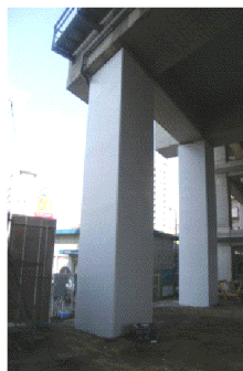
施工後 (柱に鋼板を巻き補強)
