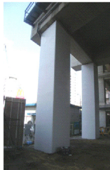
施工後 (柱に鋼板を巻き補強)
