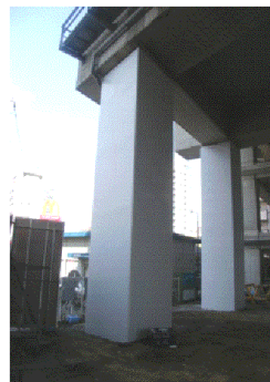
施工後 (柱に鋼板を巻き補強)
