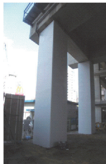
施工後 (柱に鋼板を巻き補強)
