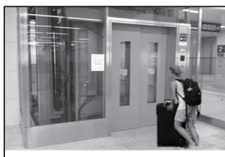
エレベーター等の設置
