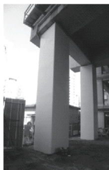
施工後 (柱に鋼板を巻き補強)
