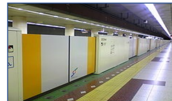
可動式ホーム柵の設置
