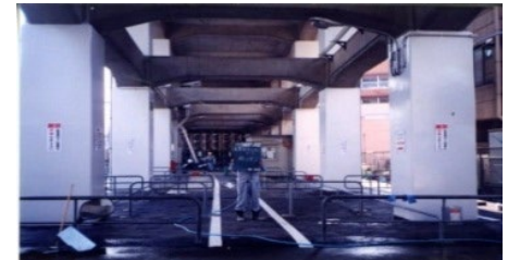
高架橋の耐震対策
