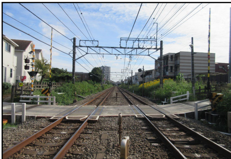
写真:新宿線 東村山第6号踏切
