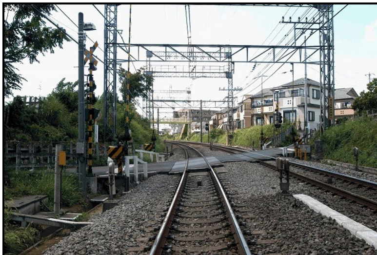
写真：池袋線 西所沢第3号踏切
