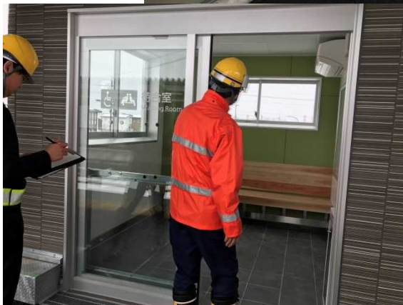
現場調査の様子 (工事現場で状況確認)
